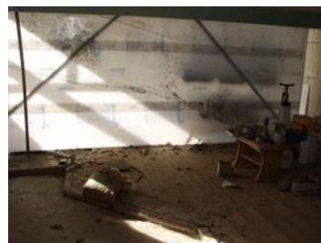
Rohbau des Pools
